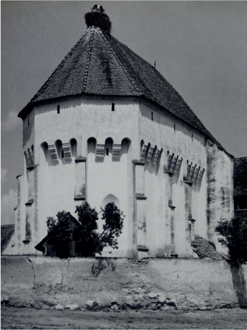
Abb. 91: Doștat-Buzd/Bușd, Rumänien/Siebenbürgen. Der verteidigungsfähige Chorüberbau erlaubt über die nach unten offenen Mauervorkragungen (Maschikulis), Angreifer an den Chormauern zu bewerfen.
