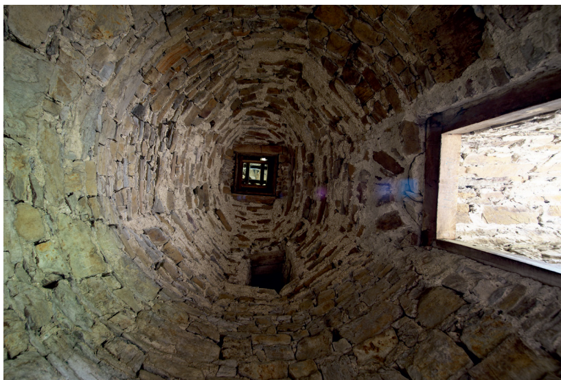
Abb. 63: Nur eine nachträglich veränderte Schießscharte belichtete den Raum. Das „Angstloch“ in der (als Pseudogewölbe eingebauten) Kuppel war ursprünglich der einzige „Zugang“. (Foto: Roland Pieper, 2019)
