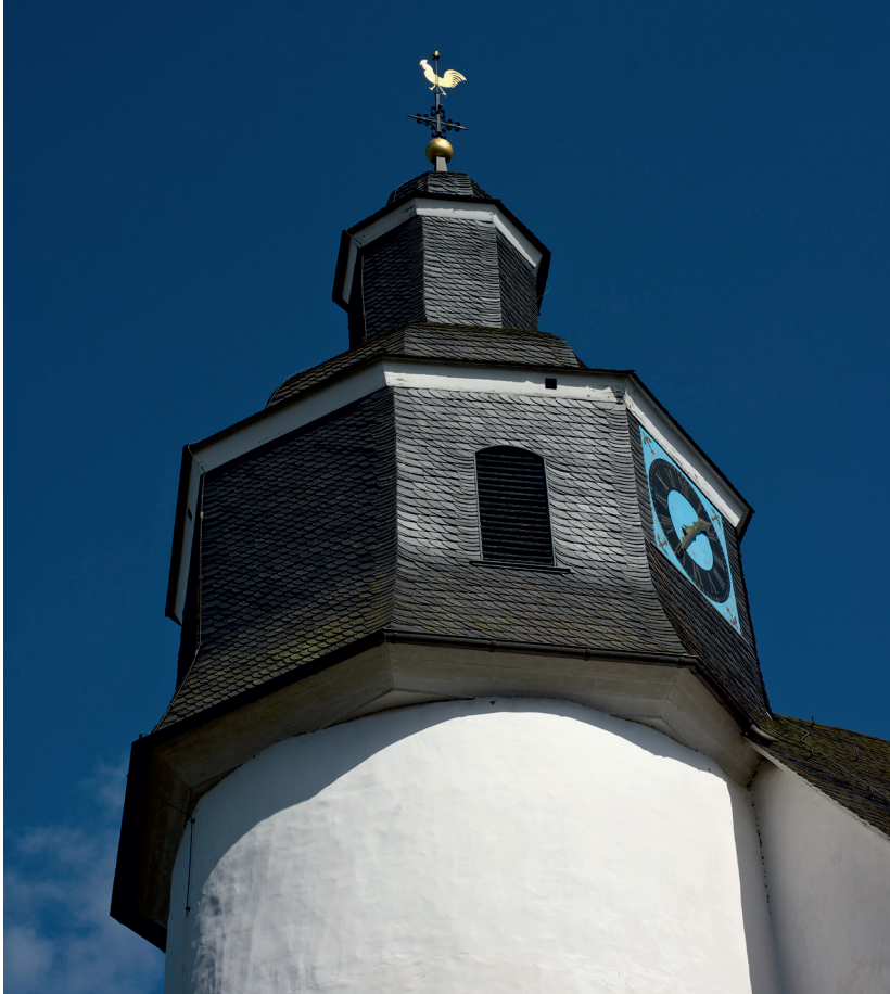
Abb. 70: Das Glockengeschoss des Turmes aus verschiefertem Fachwerk diente vermutlich auch als Brandwachstube, wie der komfortable Treppenzugang im Dachraum der Kirche und die Öffnungsklappen nahe legen.
