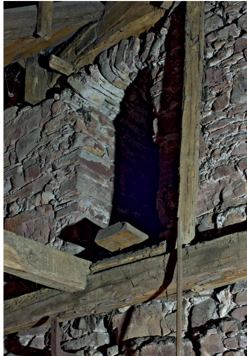
Abb. 68: Eine heute funktionslose Maueröffnung verweist auf eine Balkenlage als Zwischengeschoss innen und vermutlich eine Pechnase oder einen Ausguck außen ins Tal.
