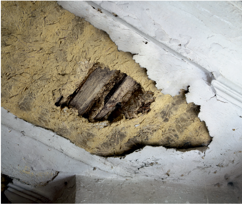
Abb. 49: Der Deckenaufbau im Westbereich der Kirche. Teils zweitverwendete Wellerhölzer wurden mit Lehmputz verstrichen. Erkennbar sind Reste von Stuckprofilen. (Foto: Roland Pieper, 2022)
