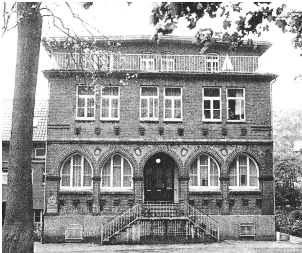
Abb. 18: Das Eckardtshaus im Zionswald kurz vor dem Abriss 1981 (Foto: Wilfried Diekmann, Gütersloh)
