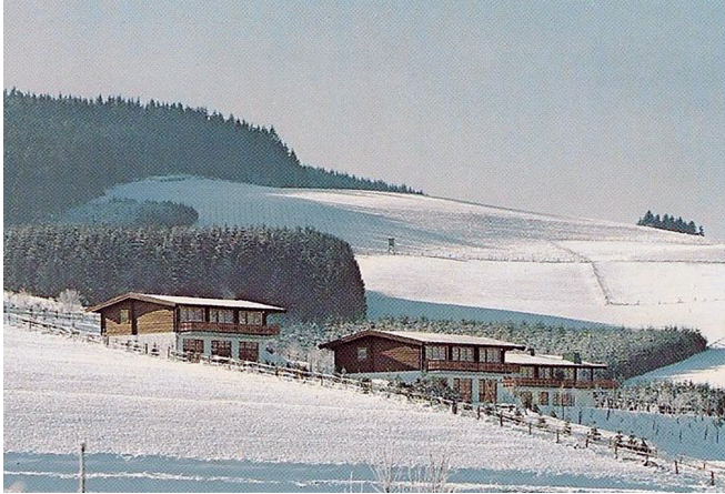
Abb. 6: Das Jugendfreizeitzentrum Wemlighausen in seiner ersten Ausbaustufe (Foto: AdKW, Sup.-Gen. 1025,1)
