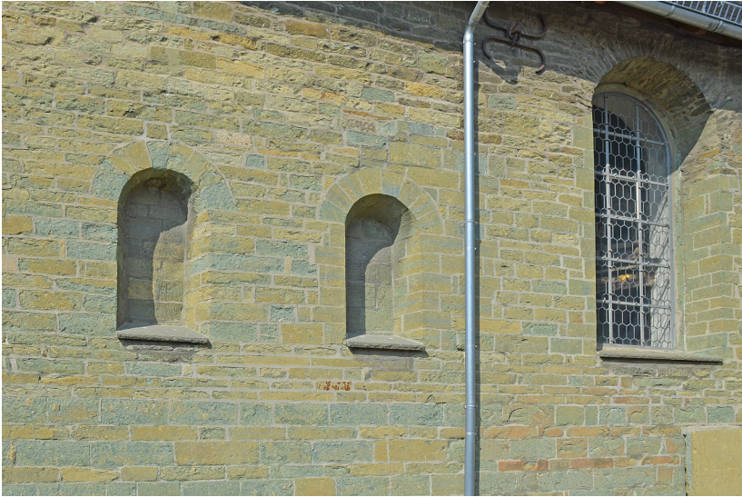
Abb. 3: Erhaltene romanische Südwand von 1250 mit zugemauerten romanischen Fenstern. (Foto: Alexander Baimann, 2022)
