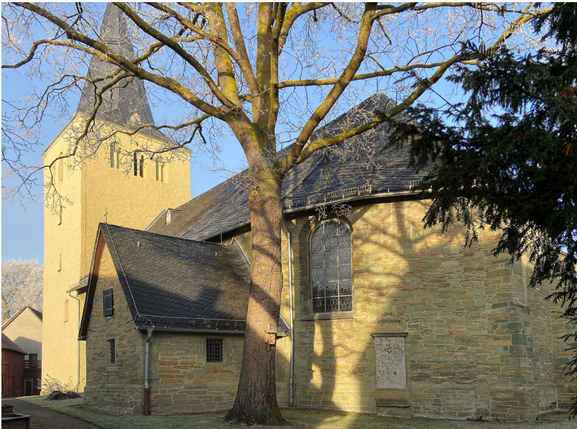
Abb. 1: Gesamtansicht der St. Severin Kirche zu Schweve. (Foto: Alexander Baimann, 2021)
