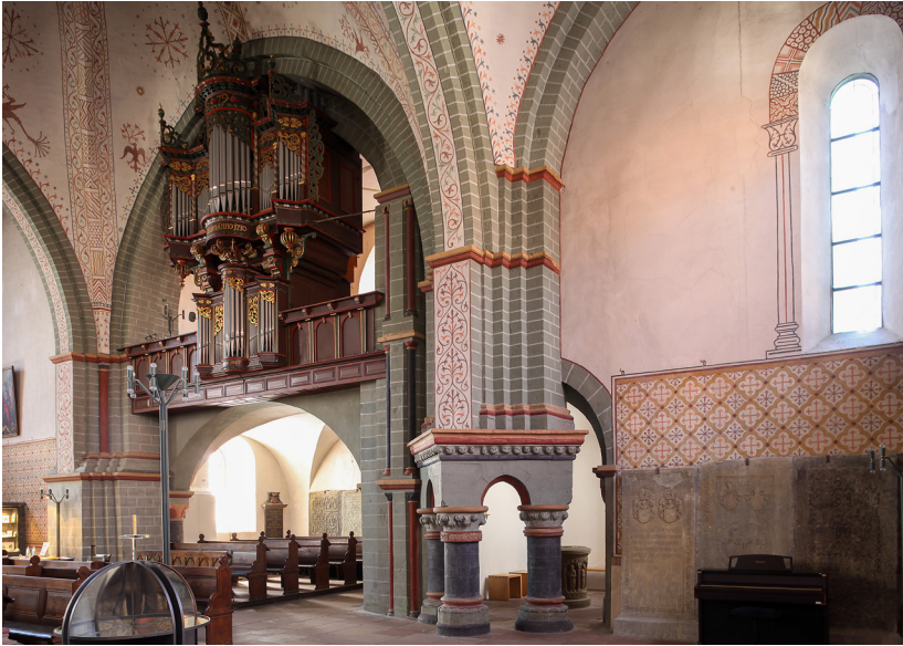
Abb. 2: Soest, Hohnkirche, Inneres nach Südwesten.
