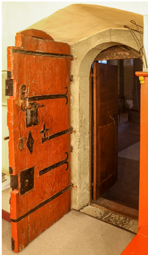
Abb. 12: St. Mariae zur Höhe (Hohnekirche) in Soest. Sakristeitür, undatiert. (Foto: Ulrich Althöfer, EKvW, Bau – Kunst – Denkmalpflege, Inventarisierung des kirchlichen Kunstgutes)
