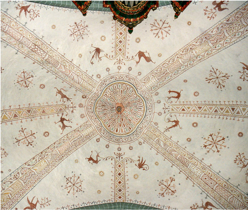
Abb. 1: Das Gewölbe im Kirchenschiff. (Foto: Peter Kubath)
