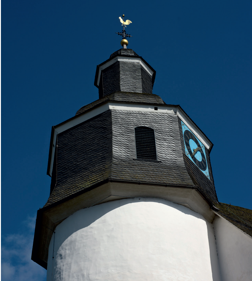
Abb. 70: Das Glockengeschoss des Turmes aus verschiefertem Fachwerk diente vermutlich auch als Brandwachstube, wie der komfortable Treppenzugang im Dachraum der Kirche und die Öffnungsklappen nahe legen. (Foto: Roland Pieper, 2019)
