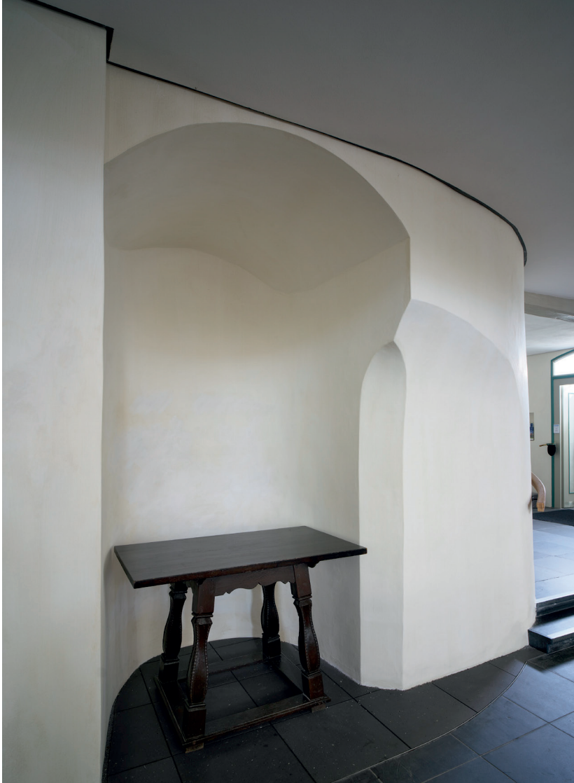
Abb. 79: Die 2021 geöffnete Ofennische in der Kirchenwestwand am Turmansatz. Vermutlich wurde sie nachträglich eingetieft und mindestens einmal umgebaut, schließlich 1961 geschlossen. (Foto: Roland Pieper, 2022)
