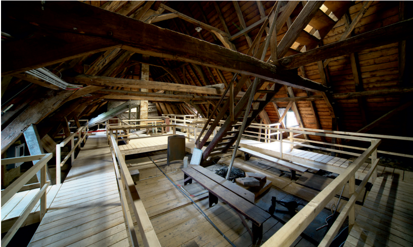
Abb. 54: Blick in das Dachwerk der Kirche nach den Restaurierungen 2019–2021. Die Schutt-Auffüllung über der Kirchendecke als Brandschutz wurde belassen, aber abgedeckt und um Laufgänge ergänzt. (Foto: Roland Pieper, 2022)
