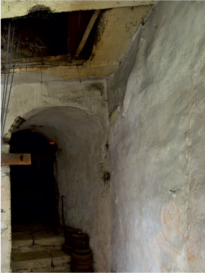
Abb. 64: Der Zugang zum Turmraum über dem Gewölbe erfolgt über einen gegen den Kirchenraum abgekleideten Gang, von dem aus auch das Westfenster der Vorkirche (ehem. Tür) erreichbar ist.
