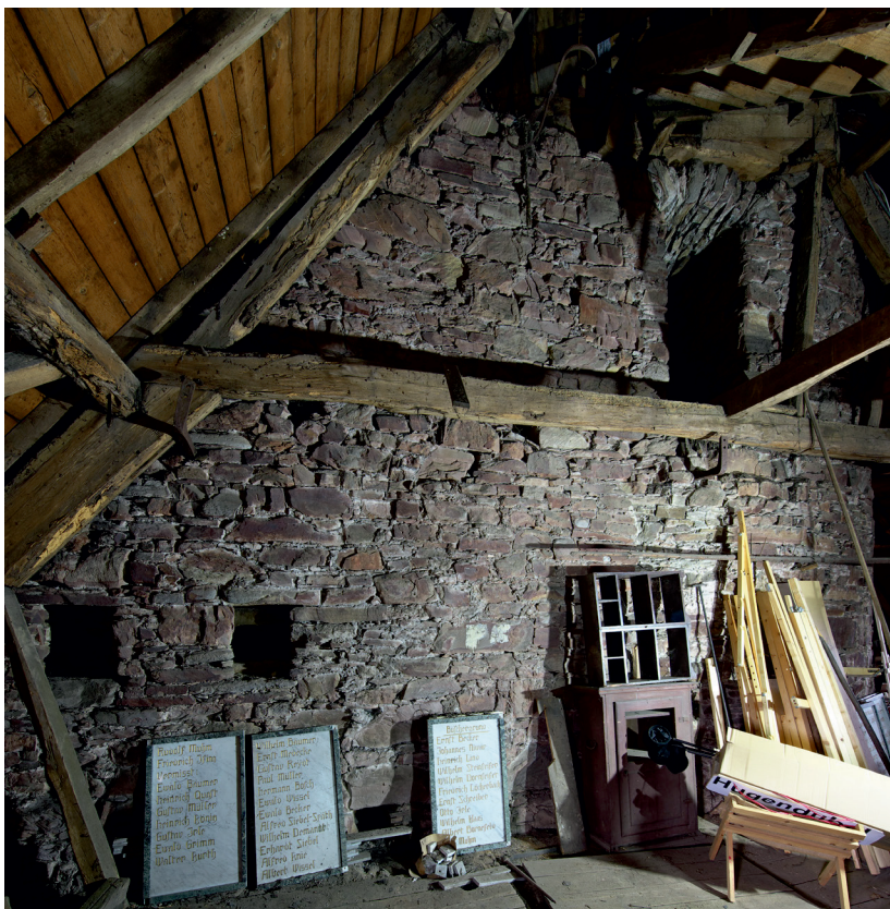
Abb. 53: Turm und Kirchenwestwand im Dachbereich der Kirche von Osten. Hier finden sich Hinweise auf Ausbauten am Turm vor Bau der Kirche und auf das vermutete Dachwerk der Kirche vor dem Brand 1666. Links im Bild die beiden Schießscharten, die über die Stadtmauer hinweg zielten, darunter stehen Platten des abgebauten Kriegerehrenmals.
