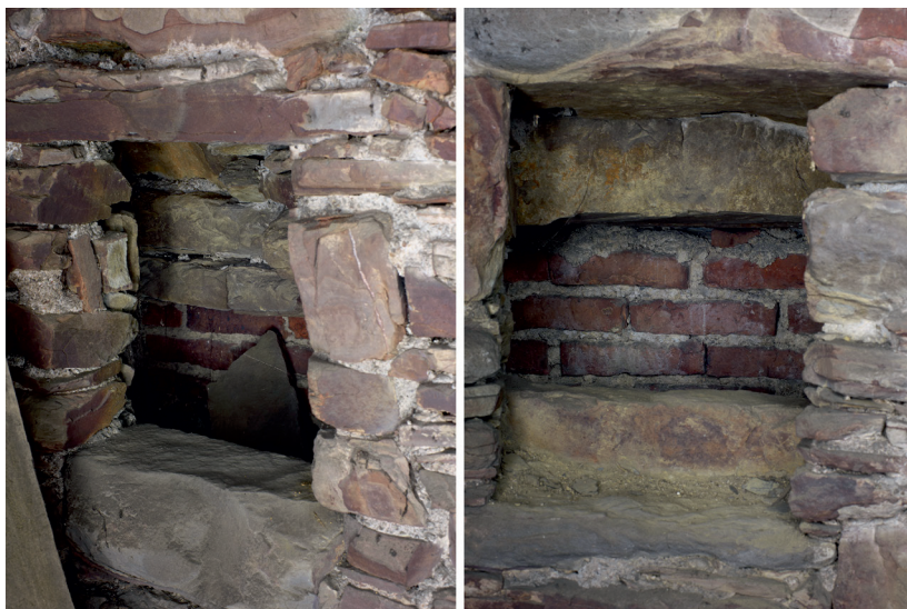
Abb. 55 u. 56: Die beiden Schießscharten in der Westwand im Dachbereich. Die linke der beiden Schießscharten zielt schräg nach links unten auf den nahen Bereich vor der Stadtmauer. Die rechte der beiden Schießscharten in der Westwand im Dachbereich zielt flach nach unten in den entfernteren Bereich vor der Stadtmauer und hat eine Sandsteinauflage für die Waffe. (Fotos: Roland Pieper, 2019)
