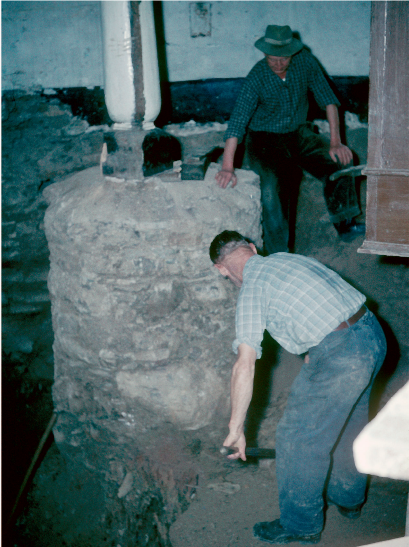
Abb. 82: Als die Kirche 1626–1632 und 1636–1645 unter jesuitischer Leitung erneut katholisch wurde, wurde auch ein Taufstein angeschafft. Dessen Fundament, auf dem vermutlich 1862 eine Emporenstütze für die Orgel Halt fand, wurde bei Einbau des Heizungskellers 1961 gefunden. (Arch EvKG Fbg, Fotosammlung, Dias, Nr. 2)
