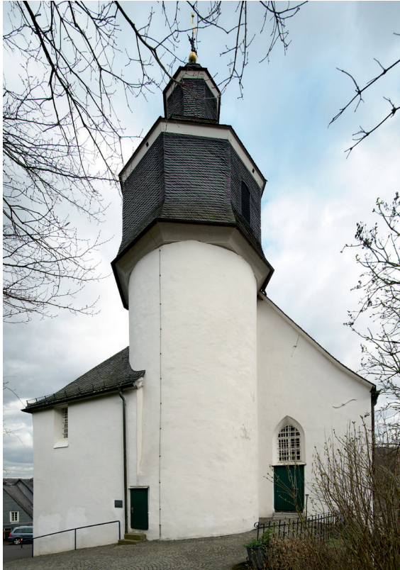
Abb. 17: Außenansicht der Kirche von der Westseite (Foto: Roland Pieper, 2019)
