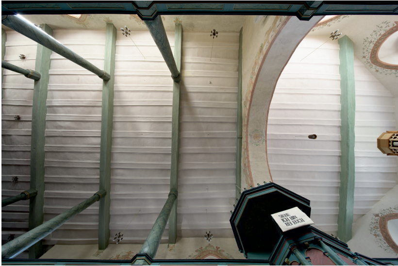
Abb. 29: Die im Gemeinderaum von drei Stützenpaaren getragene Balkendecke. (Foto: Roland Pieper, 2019)
