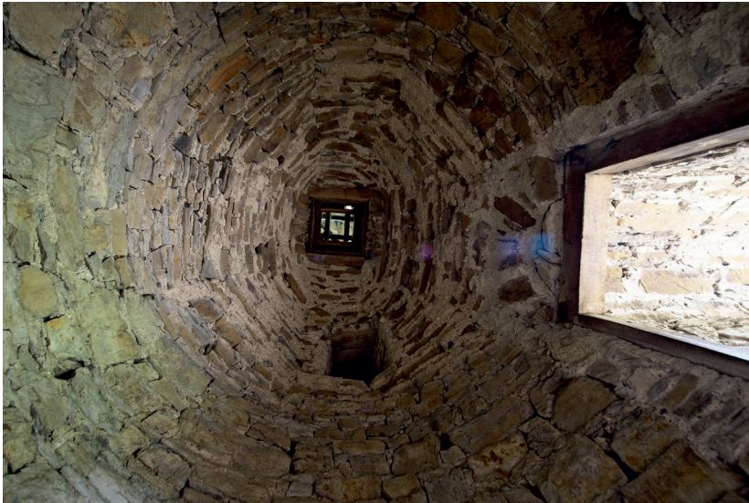
Abb. 63: Nur eine nachträglich veränderte Schießscharte belichtete den Raum. Das „Angstloch“ in der (als Pseudogewölbe eingebauten) Kuppel war ursprünglich der einzige „Zugang“.
