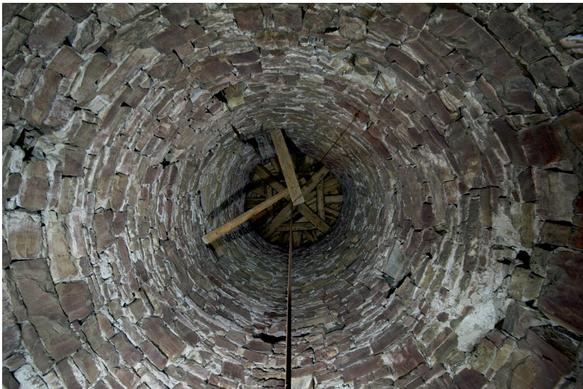
Abb. 67: Blick in den Turmschaft nach oben zur Decke des Glockengeschosses. Das flache Brett markiert die alte Turmöffnung aus der Zeit vor dem Kirchenbau. (Foto: Roland Pieper, 2019)
