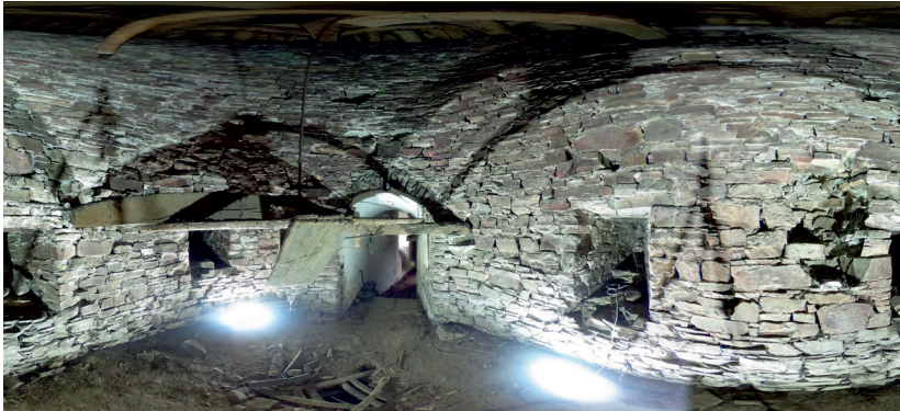
Abb. 65: Die 360°-Aufnahme zeigt die Abwicklung des Mauerwerks mit Zugang und drei Schießscharten. Unten ist das „Angstloch“ erkennbar, die Holzeinbauten gehören zu einer früheren Turmuhr. (Foto: Roland Pieper, 2019)
