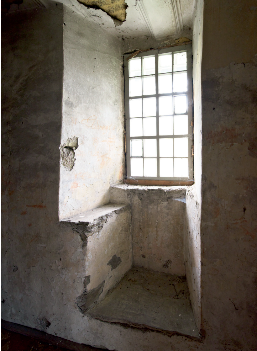
Abb. 43: Die Fensternische ist unterhalb des Fensters weniger stark vermauert, was für eine ursprüngliche Türöffnung spricht. Integriert ist eine Sitzbank. (Foto: Roland Pieper, 2019)
