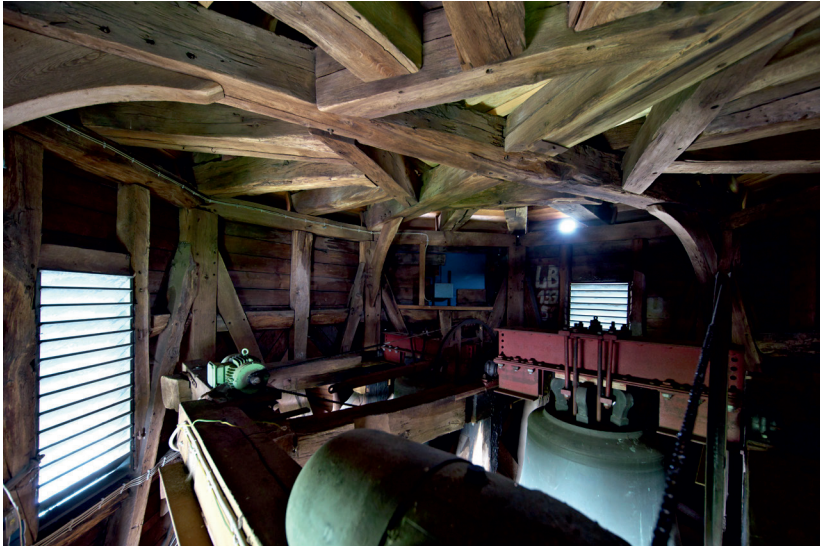
Abb. 72: Blick in das Glockengeschoss mit der Aussteifung für die Haube und deren Aufsatz durch die Balkenlage. (Foto: Roland Pieper, 2019)
