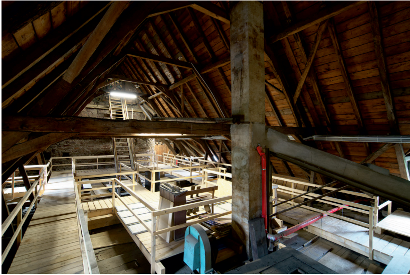
Abb. 71: Dachbereich im Blick nach Westen mit Treppenaufgang ins Glockengeschoss, dem Kamin von 1910 (im Vordergrund rechts) sowie der Windmaschine für die 1963 abgebaute Orgel. (Foto: Roland Pieper, 2022)
